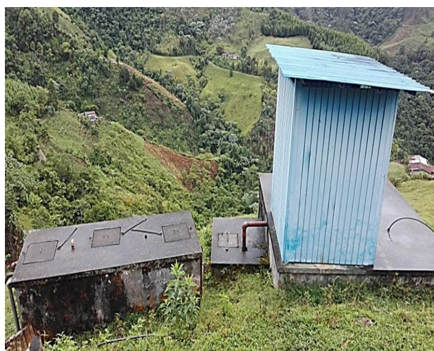
2. Tanque desarenador
