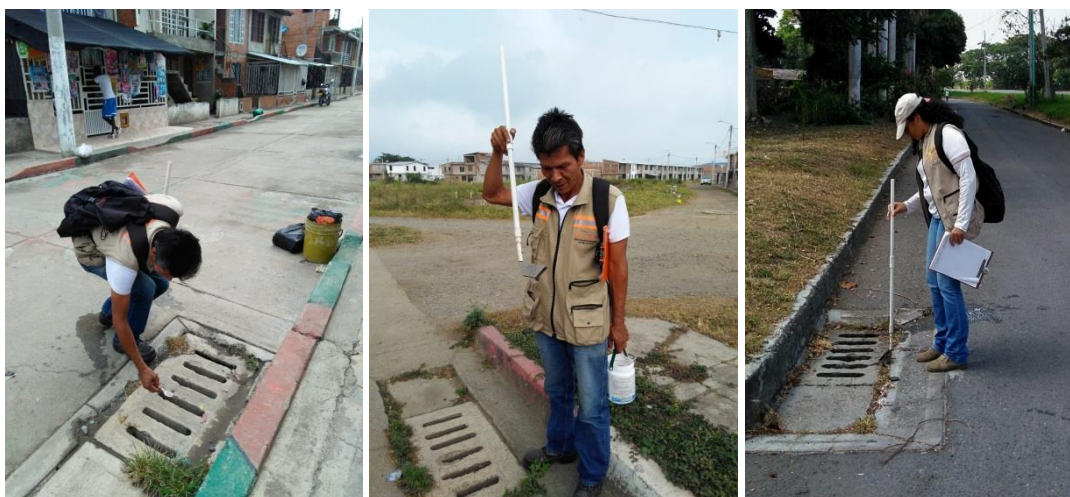
Figura 2. Inspección y Tratamiento de Sumideros de agua lluvia en vía pública
